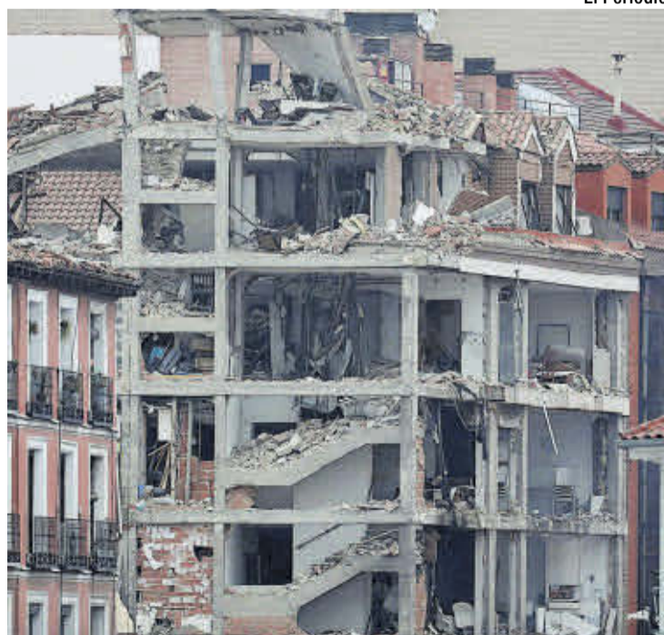
Madrid. Así quedó de dañado el edificio tras la explosión de gas.
